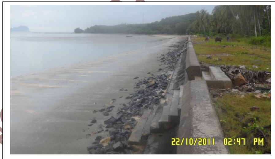
ภาพที่ 3 - 19 กำแพงกันคลื่นที่เกาะสุกร ต.เกาะสุกร อ.ปะเหลียน จ.ตรัง
