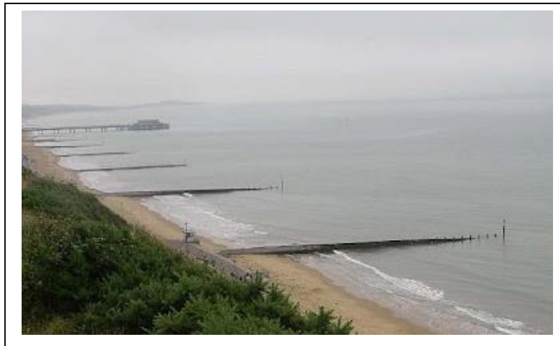
ภาพที่ 3 - 20 คันดักทรายที่สร้างขึ้นตั้งฉากกับแนวชายฝั่งทะเล
